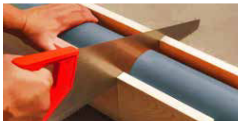
Obrázek 1 Zkracování trubky pilkou
