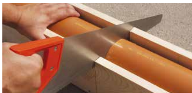
Obrázek 2 Zkracování trubky pilkou
