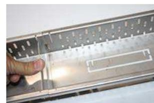
4. Fixační spojku zatlačte do zářezů, čímž dojde k pevnému spojení obou žlabů
