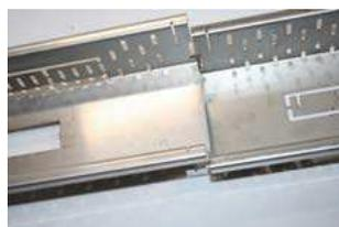
2. Spojte dva žlaby zasunutím do sebe (dbejte na to, aby jste navazovali žlab s výčnělkem na žlab s hladkým koncem)
