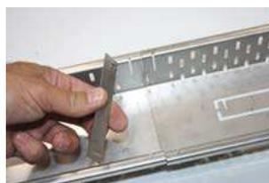
3. Uvolněnou fixační spojku nasadíte do zářezů na okraji žlabu
