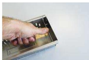
3. Fixační spojku zatlačte do zářezů, čímž dojde k pevnému spojení obou žlabů
